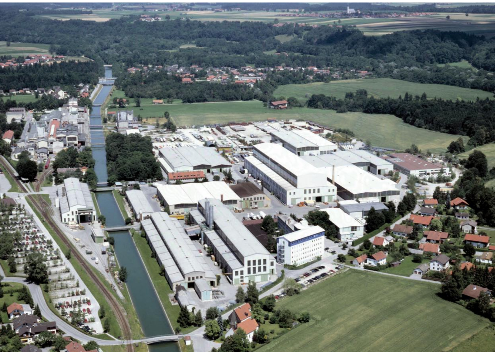
Завод в пос. Шальхен, примерно 90км к востоку от Мюнхена (Германия)
