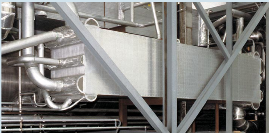
Смонтированный холодильный бокс
