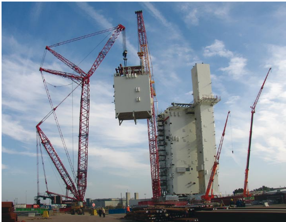
Сборка холодильного бокса для норвежского проекта Хамерфест в спутниковом портале порта г.Антверпен (Бельгия)
